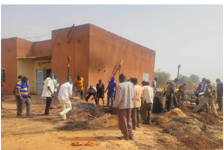
Après l'attaque de février 2023, la population aide à reconstruire le poste de police qui a brûlé.
