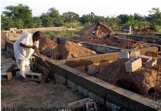
Afrikanische Zuversicht: Bauen soweit das Geld reicht
