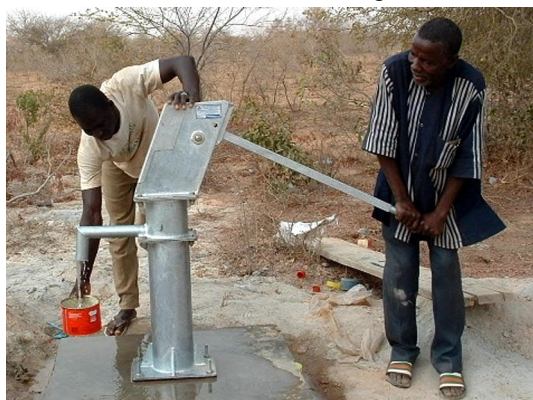
6 m 3 Wasser pro Stunde fördert der neue Brunnen
