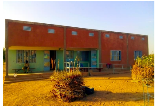
Dans ce bâtiment, de l'espace a été créé pour de nouvelles tâches. L'entrée à gauche mène désormais au bureau où est géré la coordination du travail des bénévoles. Au centre, le dépôt, à droite, la salle de consultation de Timothée Tindano.
