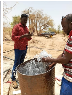
Essai de la nouvelle pompe
