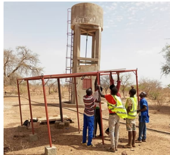
Le montage de 2 panneaux solaires supplémentaires
