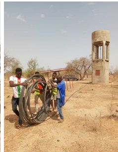
Installation de la tuyauterie vers le forage
