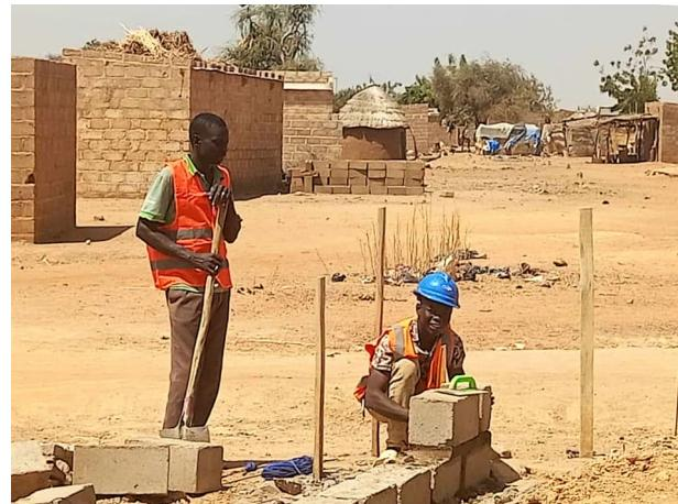
Bereits **Mitte Februar** ist der 670 m lange Graben rund um das Gelände tief genug. Große Feldsteine werden herbei geschafft und in den Graben verfüllt. Mit Beton ausgegossen entsteht so der tragende Fuß der Mauer, auf dem die erste Reihe aus massiven Steinen gesetzt wird.
