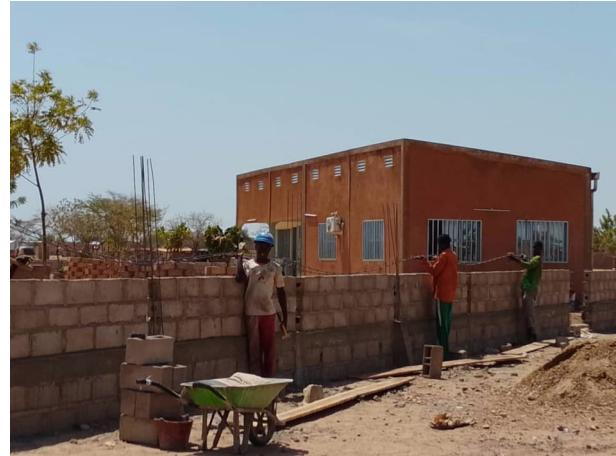
**Anfang April** sind die ersten zwei Steinreihen aufgemauert. Jetzt ist die Zeit für den ersten „Ringanker“ gekommen. Die Schalung wird angebracht und ein Geflecht aus Baustahl eingelegt. Anschließend wird die Schalung mit Beton ausgegossen. Der so entstandene durchlaufende Betonring stabilisiert die Mauer. Nach weiteren drei Reihen Steinen wird wieder ein solcher Ringanker betoniert.
