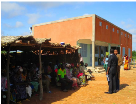
Das neue Behandlungsgebäude wird im August 2017 in Betrieb genommen
