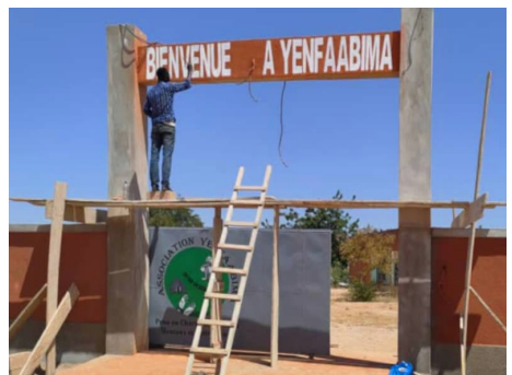
Letzte Arbeiten am Eingangsportal
